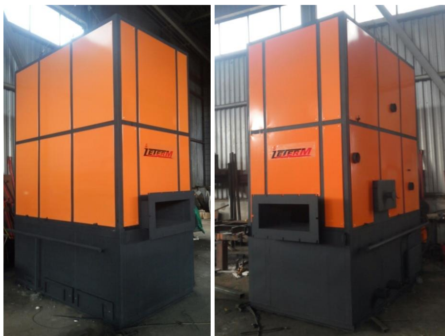
Рис. 10. Водогрейный котел КВм-5,0ДВО, установленный в республике Беларусь
