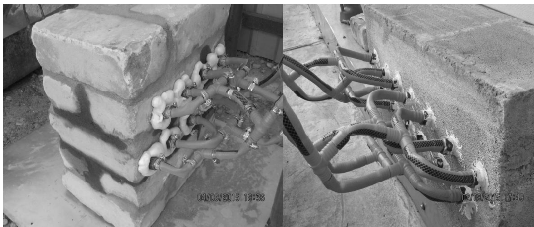
Рис. 3. Испытания по устройству объемной гидрофобизации
